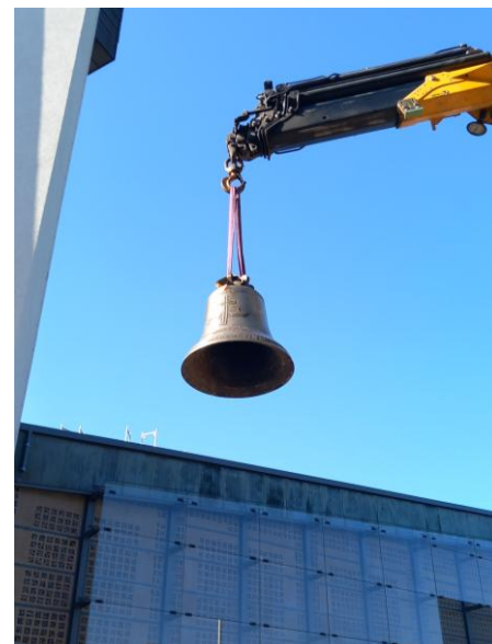
Die neue Glocke wird auf den Kirchturm in St. Ulrich gezogen
